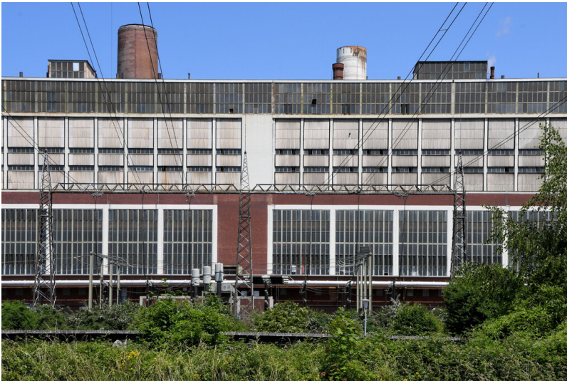
Kraftwerk Weisweiler: Anschlussleitungen vom Portalgerüst der Freiluft-Schaltanlage Block E zur Hochspannungsleitung, Ansicht von Nordosten; Foto: 16.06.2023 Fotograf/Urheber: Dr. Norbert Gilson
