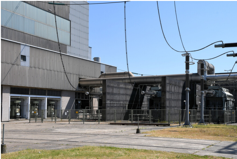
Kraftwerk Weisweiler: Maschinentransformator-Pole U, V, W (jeweils 21/380 kV, 266 MVA), Ansicht von Südwesten; Foto: 13.06.2023 Fotograf/Urheber: Dr. Norbert Gilson
