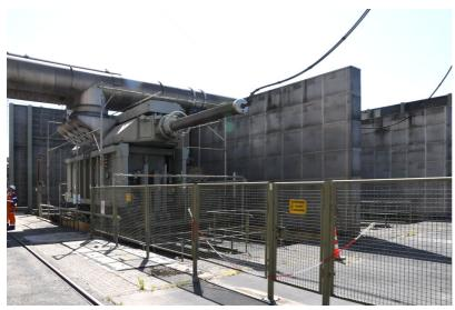
Kraftwerk Weisweiler: Maschinentransformatorpol Block G (21/380 kV, 266 MVA), Ansicht von Nordwesten; Foto: 13.06.2023 Fotograf/Urheber: Dr. Norbert Gilson
