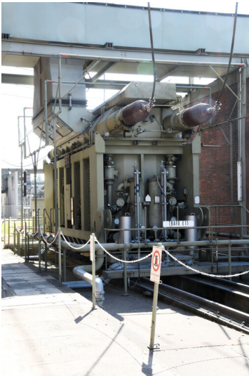
Kraftwerk Weisweiler: Maschinentransformator E 11 Block E (21/110 kV, Hersteller Brown, Boveri & Cie.), Ansicht von Nordwesten; Foto: 13.06.2023 Fotograf/Urheber: Dr. Norbert Gilson
