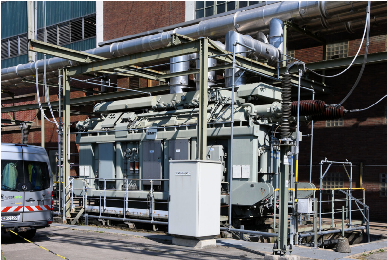
Kraftwerk Weisweiler: Maschinentransformator 2 (21/110 kV Block F, Hersteller Royal Smit Transformers B.V.), Ansicht von Südosten; Foto: 13.06.2023 Fotograf/Urheber: Dr. Norbert Gilson
