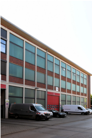
Kraftwerk Weisweiler: Schaltanlagegebäude ""Zukunft"", Ansicht von Nordwesten; Foto: 16.06.2023 Fotograf/Urheber: Dr. Norbert Gilson
