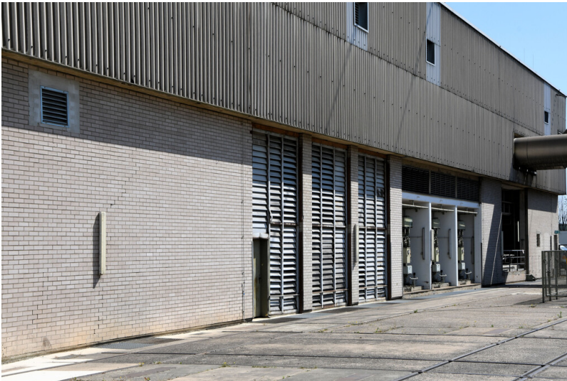
Kraftwerk Weisweiler: Schaltanlagenvorbau Block H, Ansicht von Südwesten; Foto: 13.06.2023 Fotograf/Urheber: Dr. Norbert Gilson
