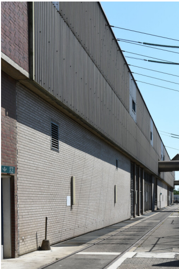
Kraftwerk Weisweiler: Schaltanlagenvorbau Block G, Ansicht von Südwesten; Foto: 13.06.2023 Fotograf/Urheber: Dr. Norbert Gilson
