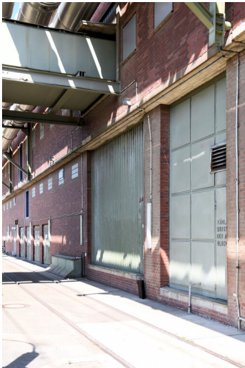
Kraftwerk Weisweiler: Schaltanlagenvorbau Block E, Ansicht von Südosten; Foto: 13.06.2023 Fotograf/Urheber: Dr. Norbert Gilson
