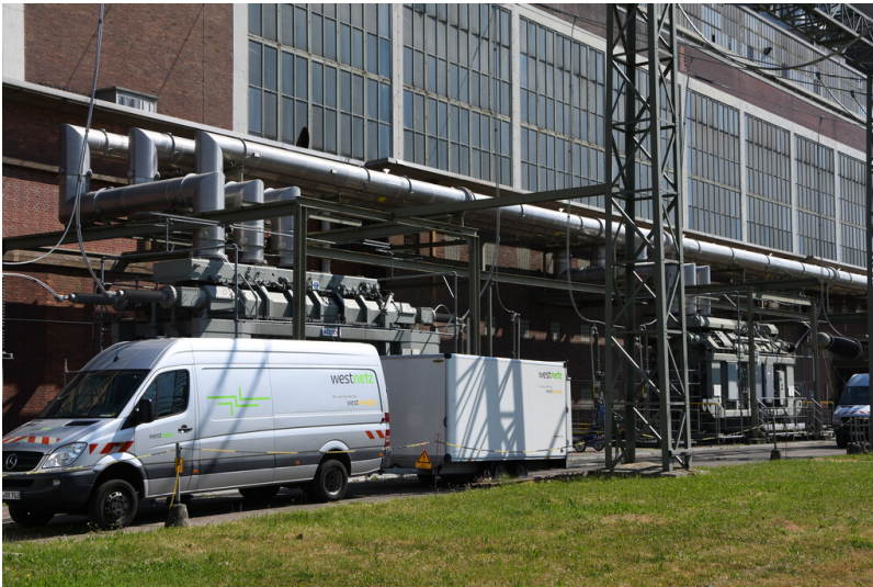
Kraftwerk Weisweiler: Schaltanlagenvorbau Block D, Ansicht (von Fahrzeug verdeckt) von Südwesten; Foto: 13.06.2023 Fotograf/Urheber: Dr. Norbert Gilson
