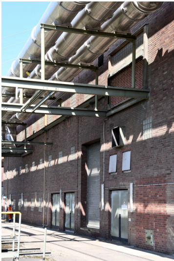
Kraftwerk Weisweiler: Schaltanlagenvorbau Block C, Ansicht von Südosten; Foto: 13.06.2023 Fotograf/Urheber: Dr. Norbert Gilson
