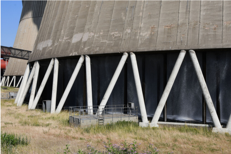
Kraftwerk Weisweiler: Kühlturm H, Detail der Konstruktion; Foto: 13.06.2023 Fotograf/Urheber: Dr. Norbert Gilson
