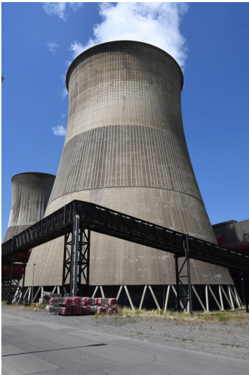
Kraftwerk Weisweiler: Kühlturm G, Ansicht von Osten; Foto: 13.06.2023 Fotograf/Urheber: Dr. Norbert Gilson
