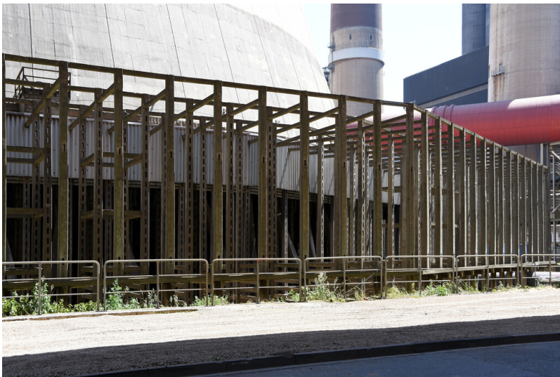
Kraftwerk Weisweiler: Kühlturm F, Vorbau mit Rieselementen, Ansicht von Nordwesten; Foto: 13.06.2023 Fotograf/Urheber: Dr. Norbert Gilson
