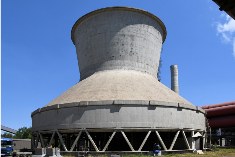
Kraftwerk Weisweiler: Kühlturm 12, Ansicht von Südwesten; Foto: 13.06.2023 Fotograf/Urheber: Dr. Norbert Gilson
