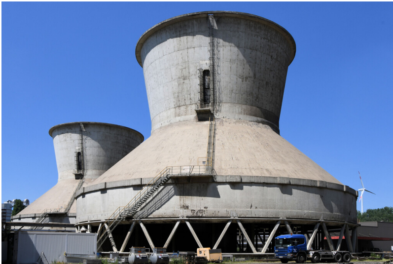
Kraftwerk Weisweiler: Kühlturm 11, Ansicht von Osten; Foto: 13.06.2023 Fotograf/Urheber: Dr. Norbert Gilson
