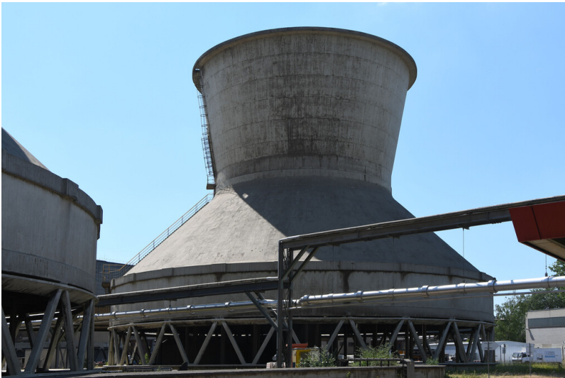
Kraftwerk Weisweiler: Kühlturm 10, Ansicht von Nordosten; Foto: 13.06.2023 Fotograf/Urheber: Dr. Norbert Gilson
