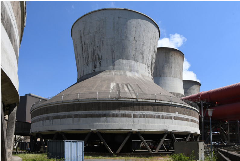
Kraftwerk Weisweiler: Kühlturm 7, Ansicht von Nordwesten; Foto: 13.06.2023 Fotograf/Urheber: Dr. Norbert Gilson
