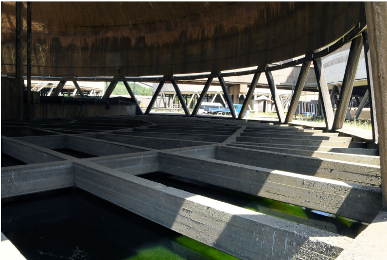
Kraftwerk Weisweiler: Kühlturm 6, Asbestzementeinbauten; Foto: 13.06.2023 Fotograf/Urheber: Dr. Norbert Gilson
