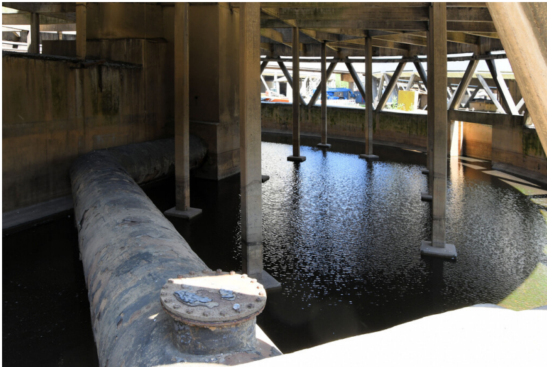
Kraftwerk Weisweiler: Kühlturm 5, Asbestzementeinbauten, Druckrohrleitung zur Einführung des Warmwassers in die Steigleitung; Foto: 13.06.2023 Fotograf/Urheber: Dr. Norbert Gilson
