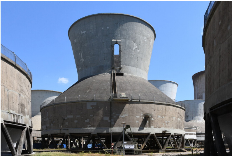
Kraftwerk Weisweiler: Kühlturm 4, Ansicht von Südwesten; Foto: 13.06.2023 Fotograf/Urheber: Dr. Norbert Gilson
