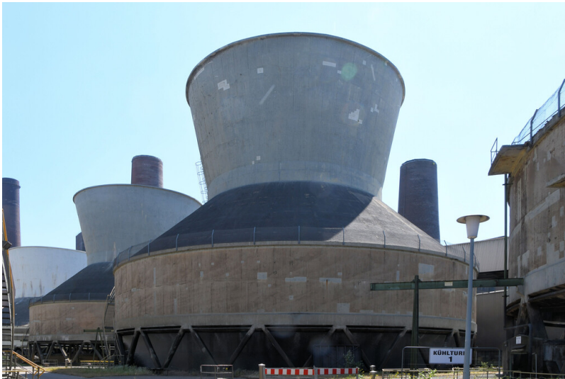
Kraftwerk Weisweiler: Kühlturm 3, Ansicht von Nordwesten; Foto: 13.06.2023 Fotograf/Urheber: Dr. Norbert Gilson
