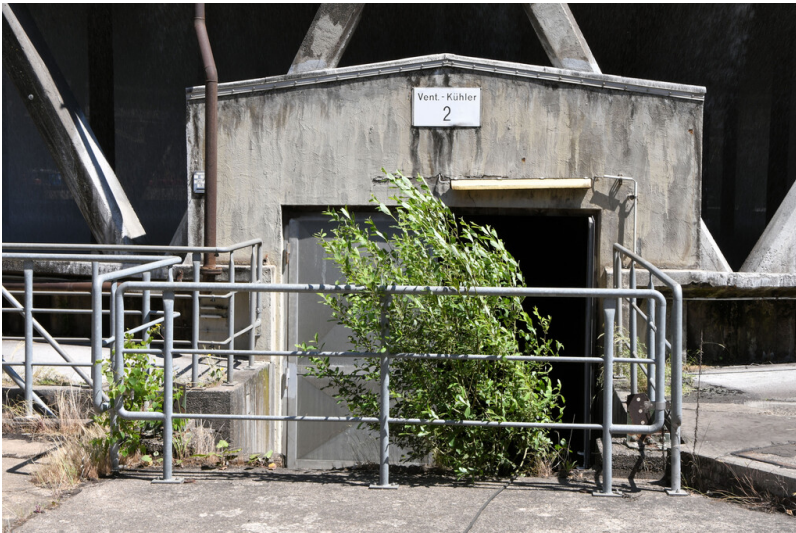
Kraftwerk Weisweiler: Kühlturm 2, Eingang zum Tunnel mit den Antriebsvorrichtungen; Foto: 13.06.2023 Fotograf/Urheber: Dr. Norbert Gilson
