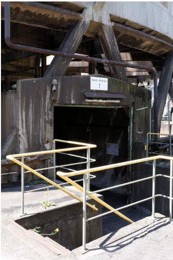
Kraftwerk Weisweiler: Kühlturm 1, Eingang zum Tunnel mit den Antriebsvorrichtungen; Foto: 13.06.2023 Fotograf/Urheber: Dr. Norbert Gilson
