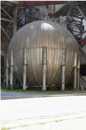
Kraftwerk Weisweiler: Notkondensatbehälter Blöcke G/H, Ansicht von Osten; Foto: 13.06.2023 Fotograf/Urheber: Dr. Norbert Gilson
