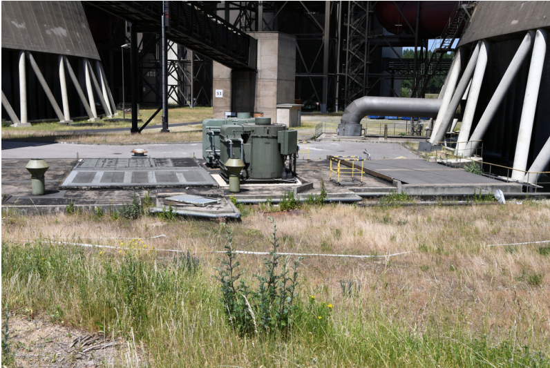
Kraftwerk Weisweiler: Kühlwasser-Pumpenhaus Block H, Ansicht von Süden; Foto: 13.06.2023 Fotograf/Urheber: Dr. Norbert Gilson
