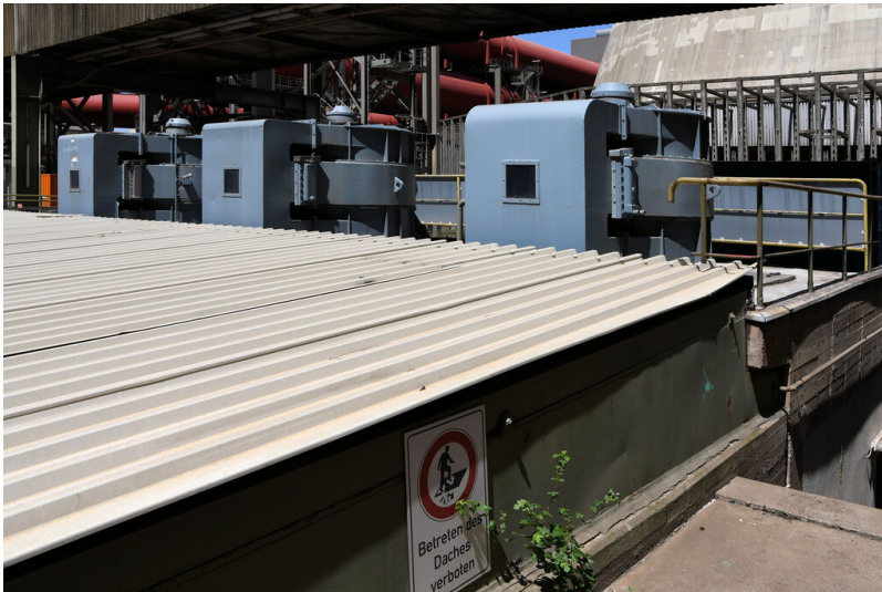
Kraftwerk Weisweiler: Kühlwasser-Pumpenhaus Block F, Ansicht von Süden; Foto: 13.06.2023 Fotograf/Urheber: Dr. Norbert Gilson
