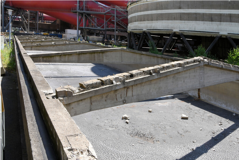
Kraftwerk Weisweiler: zentraler Kühlwasserkanal für die Blöcke A/E, Ansicht von Westen; Foto: 13.06.2023 Fotograf/Urheber: Dr. Norbert Gilson
