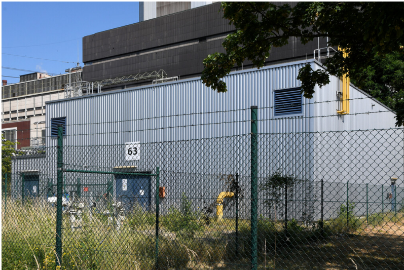
Kraftwerk Weisweiler: Gasdruckregelanlage für die Vorschaltgasturbinen Blöcke G/H, Ansicht von Südosten; Foto: 16.06.2023 Fotograf/Urheber: Dr. Norbert Gilson
