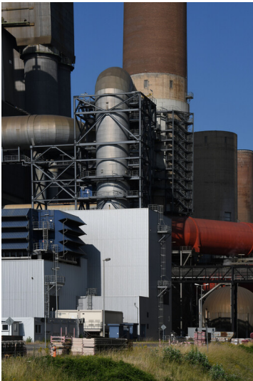
Kraftwerk Weisweiler: Vorschaltgasturbinen G/H, Abgaseinleitung in den Schornstein Block H, Ansicht von Osten; Foto: 16.06.2023 Fotograf/Urheber: Dr. Norbert Gilson
