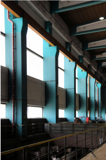
Kraftwerk Weisweiler: Maschinenhaus Block G, Innenansicht von Osten; Foto: 16.06.2023 Fotograf/Urheber: Dr. Norbert Gilson
