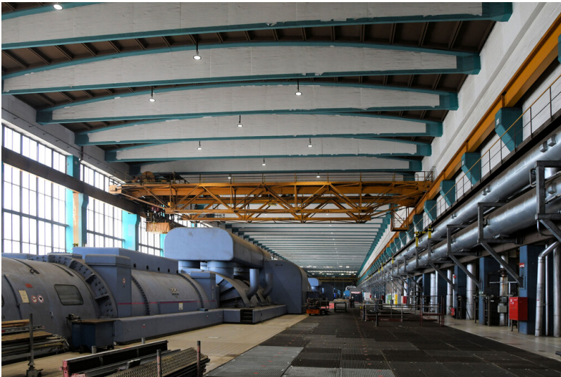
Kraftwerk Weisweiler: Maschinenhaus in Höhe Block F, Innenansicht von Osten; Foto: 16.03.2023 Fotograf/Urheber: Dr. Norbert Gilson
