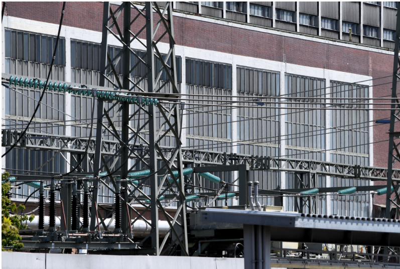
Kraftwerk Weisweiler: Maschinenhaus Block E, Ansicht von Südwesten; Foto: 13.03.2023 Fotograf/Urheber: Dr. Norbert Gilson
