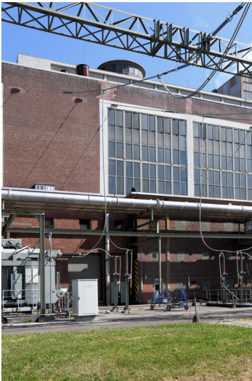
Kraftwerk Weisweiler: Maschinenhaus, Block D, Ansicht von Südwesten; Foto: 13.03.2023 Fotograf/Urheber: Dr. Norbert Gilson
