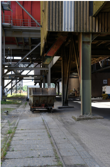
Kraftwerk Weisweiler: Ascheturm G, Notentaschungs-Vorrichtung, Ansicht von Westen; Foto: 13.03.2023 Fotograf/Urheber: Dr. Norbert Gilson
