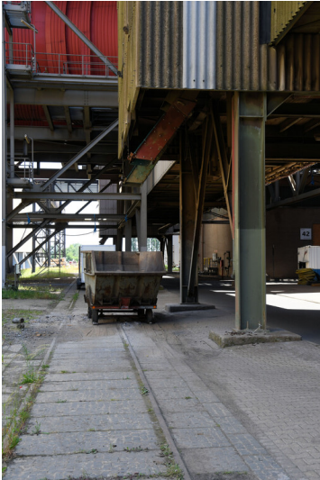
Kraftwerk Weisweiler: Ascheturm G, Notentaschungs-Vorrichtung, Ansicht von Westen; Foto: 13.03.2023 Fotograf/Urheber: Dr. Norbert Gilson
