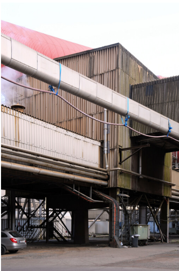
Kraftwerk Weisweiler: Ascheturm 4, Einführungen der Aschebandbrücken von den Blöcken E/F (linke Bildseite) und G/H (rechte Bildseite), Ansicht von Südosten; Foto: 16.03.2023 Fotograf/Urheber: Dr. Norbert Gilson
