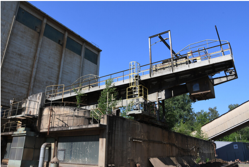
Kraftwerk Weisweiler: Aschebagger, Fahrwerkstütze, Ansicht von Nordosten; Foto: 13.03.2023 Fotograf/Urheber: Dr. Norbert Gilson
