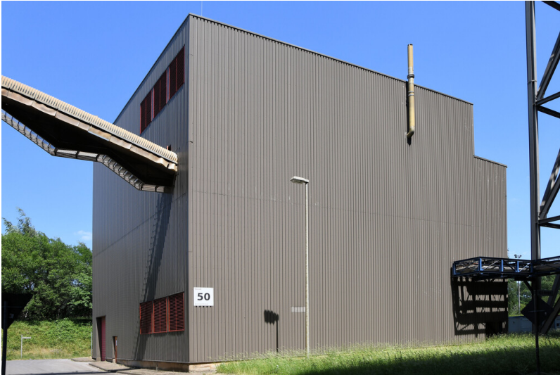
Kraftwerk Weisweiler: Feinteilausschleusung, Ausgabevorrichtung zum Gipseckturn REA, Ansicht von Südwesten; Foto: 13.06.2023 Fotograf/Urheber: Dr. Norbert Gilson
