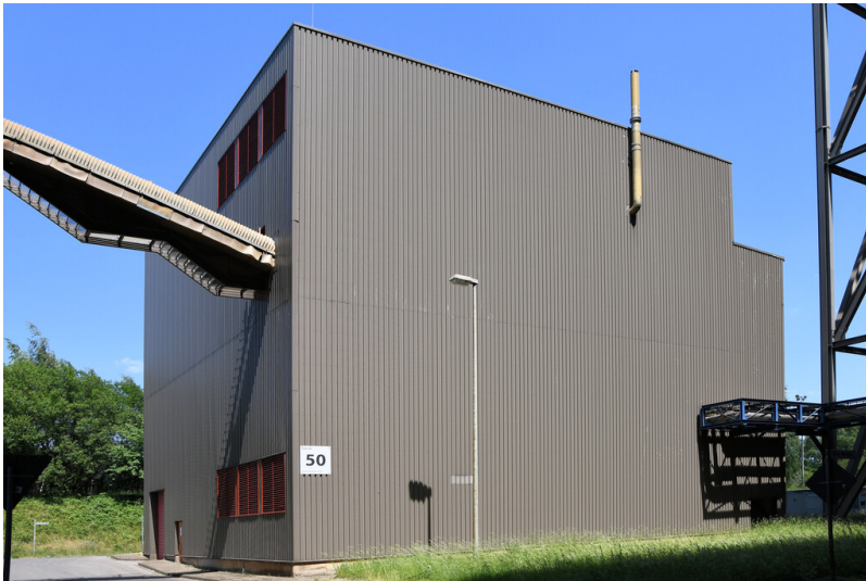
Kraftwerk Weisweiler: Feinteilausschleusung, Ausgabevorrichtung zum Gipseckturn REA, Ansicht von Südwesten; Foto: 13.06.2023 Fotograf/Urheber: Dr. Norbert Gilson
