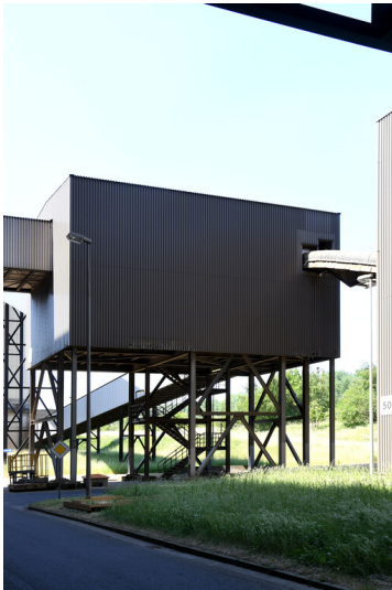
Kraftwerk Weisweiler: Gipseckturn REA, Ansicht von Osten; Foto: 13.06.2023 Fotograf/Urheber: Dr. Norbert Gilson
