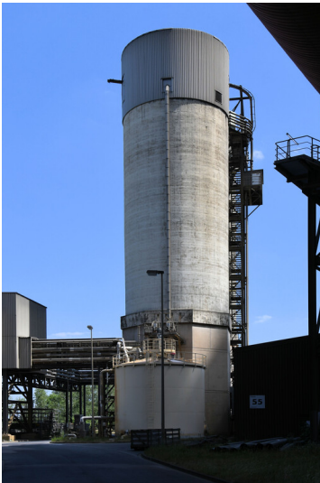
Kraftwerk Weisweiler: Kalkförderanlage, Silos für das Kalksteinmehl, davor Anmischbehälter, Ansicht von Westen; Foto: 13.06.2023 Fotograf/Urheber: Dr. Norbert Gilson
