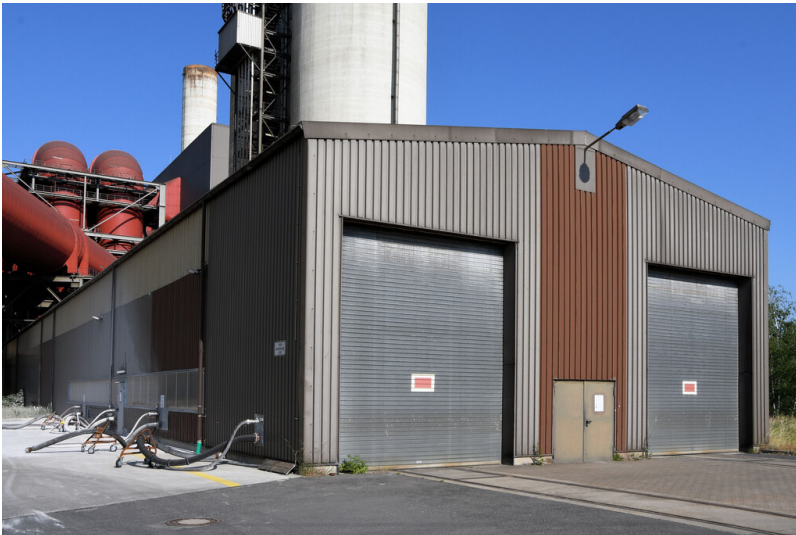
Kraftwerk Weisweiler: Kalkbahnhof, Ansicht von Südosten; Foto: 16.06.2023 Fotograf/Urheber: Dr. Norbert Gilson
