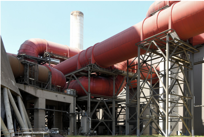
Kraftwerk Weisweiler: Reingasrohr aus Wäscherstraße G, Führung zum Kühlturm G, Ansicht von Südosten; Foto: 13.06.2023 Fotograf/Urheber: Dr. Norbert Gilson
