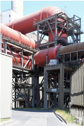
Kraftwerk Weisweiler: Reingasrohr aus Wäscherstraße F, Übergang von Stahl- zu GFK-Rohren, Stütztisch aus Stahlbeton, Ansicht von Westen; Foto: 13.06.2023 Fotograf/Urheber: Dr. Norbert Gilson
