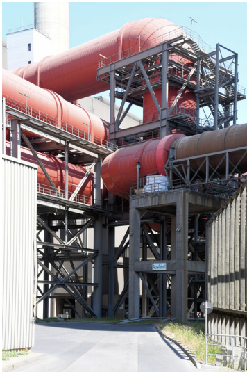
Kraftwerk Weisweiler: Reingasrohre aus Wäscherstraße F, Übergang von Stahl- zu GFK-Rohren, Stütztisch aus Stahlbeton, Ansicht von Westen; Foto: 13.06.2023 Fotograf/Urheber: Dr. Norbert Gilson
