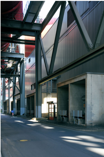
Kraftwerk Weisweiler: REA-Schaltanlagegebäude, Südseite, Ansicht von Südosten; Foto: 16.06.2023 Fotograf/Urheber: Dr. Norbert Gilson
