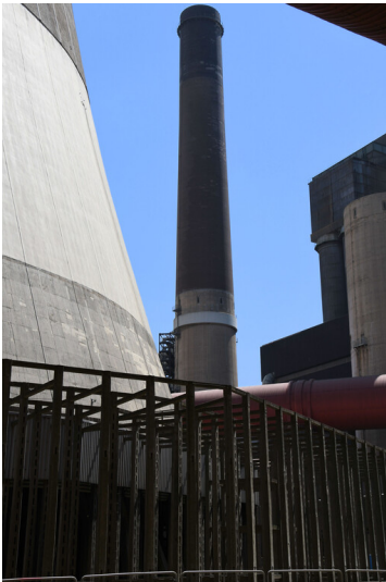
Kraftwerk Weisweiler: Schornstein Block H, Ansicht von Nordwesten; Foto: 13.06.2023 Fotograf/Urheber: Dr. Norbert Gilson
