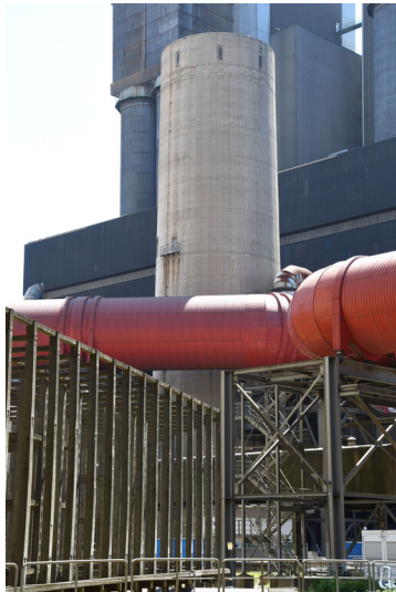
Kraftwerk Weisweiler: Schornstein-Fundamentalsockel Block G, Ansicht von Nordwesten; Foto: 13.06.2023 Fotograf/Urheber: Dr. Norbert Gilson
