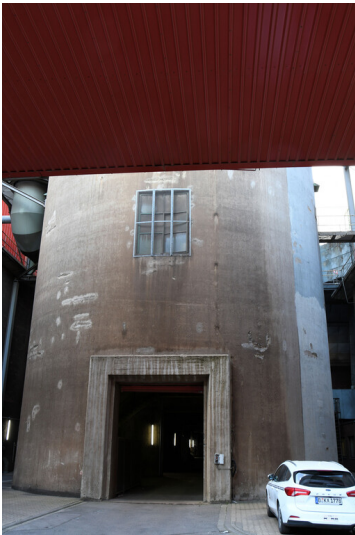
Kraftwerk Weisweiler: Schornstein-Fundamentsockel Block E, unterer Sockelbereich, Ansicht von Norden; Foto: 16.06.2023 Fotograf/Urheber: Dr. Norbert Gilson
