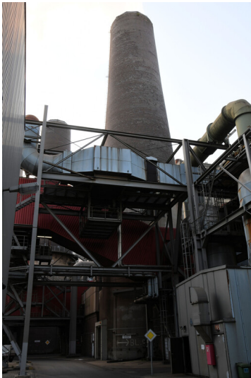
Kraftwerk Weisweiler: Rest der gemauerten Schornsteinsäule von Block C, Ansicht von Norden; Foto: 16.06.2023 Fotograf/Urheber: Dr. Norbert Gilson
