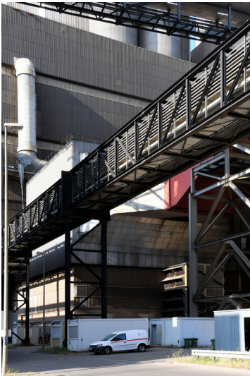
Kraftwerk Weisweiler: Elektrofilter von Block H, Ansicht von Nordosten; Foto: 16.06.2023 Fotograf/Urheber: Dr. Norbert Gilson
