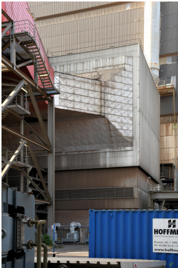
Kraftwerk Weisweiler: Elektrofilter von Block G, Ansicht von Nordwesten; Foto: 16.06.2023 Fotograf/Urheber: Dr. Norbert Gilson
